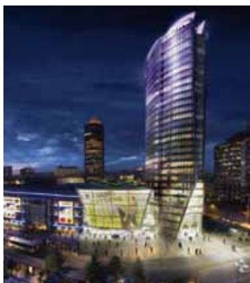
CÔTE - Réalisation de l'équipement électrique de la Tour Oxygène de Lyon.
