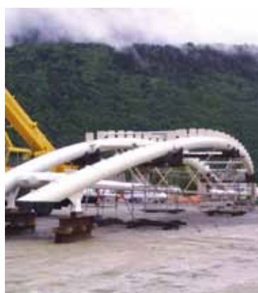
LAFAURY - Chantier de la gare de péage à Bonneville
