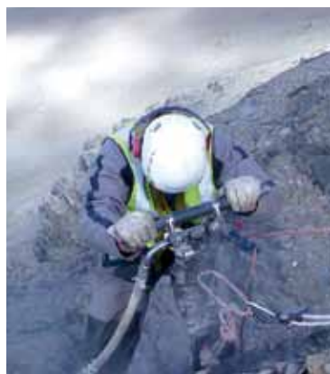
MBTM - Forage pour la pose d'un Catex, déclencheur d'avalanches
