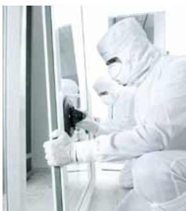
VÊPRES CONSTRUCTIONS - Intervention de poseurs en salle blanche.
