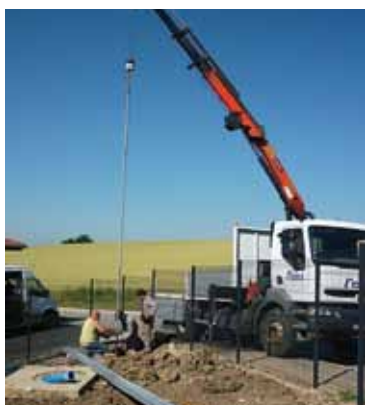
L'EAU - Installation d'une pompe immergée à 100 mètres de profondeur
