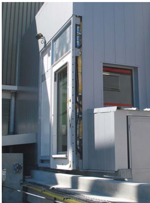
Les « gares » sont de petites extensions ISO 6 des salles propres, ajoutées pour la connexion des cabines.
