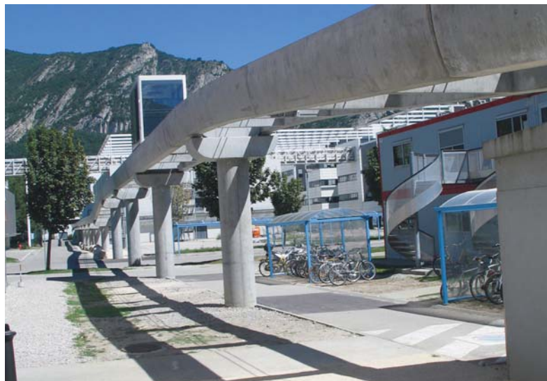
Le viaduc en béton est simplement posé sur les 16 pylônes, ce qui autorise les dilatations importantes des matériaux (en Isère, on atteint facilement 50 °C d'amplitude thermique).
