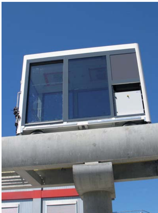
La cabine, pas encore opérationnelle. Le système d'appel est semblable à celui d'un ascenseur, en va-et-vient.
