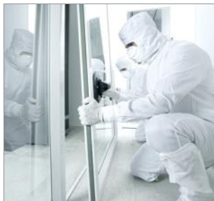
Techniciens de Vêpres à l'œuvre sur la réalisation d'une salle blanche. Photo Vêpres
